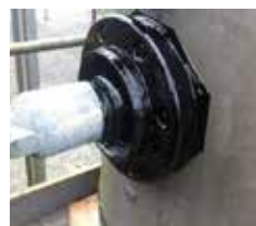
Sellado de fugas en transformador
