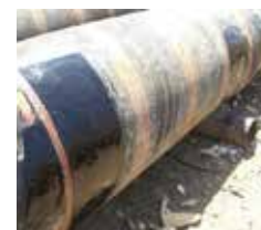
Reparación de manguera flotante
