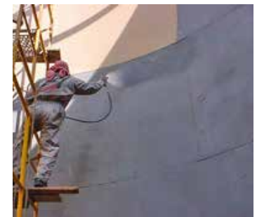
Revestimiento de tanques
