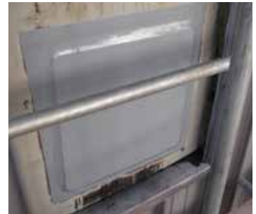
Protección de reparaciones
